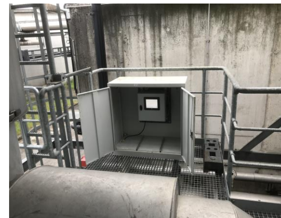
Una imagen de la unidad instalada en el cabinet para mayor protección contra la intemperie
