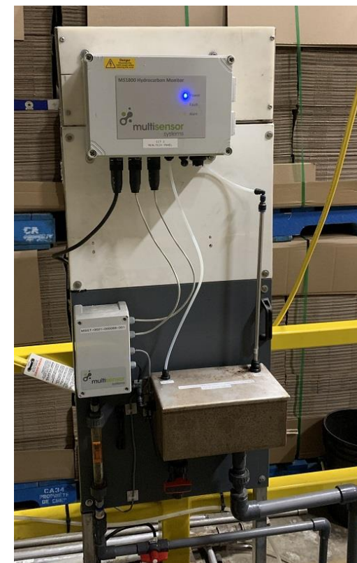
El analizador MS1900 instalado cerca del efluente.
